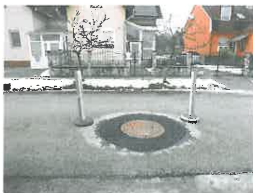
Csatornafedlap javítása a Ritter F. u.-ban
