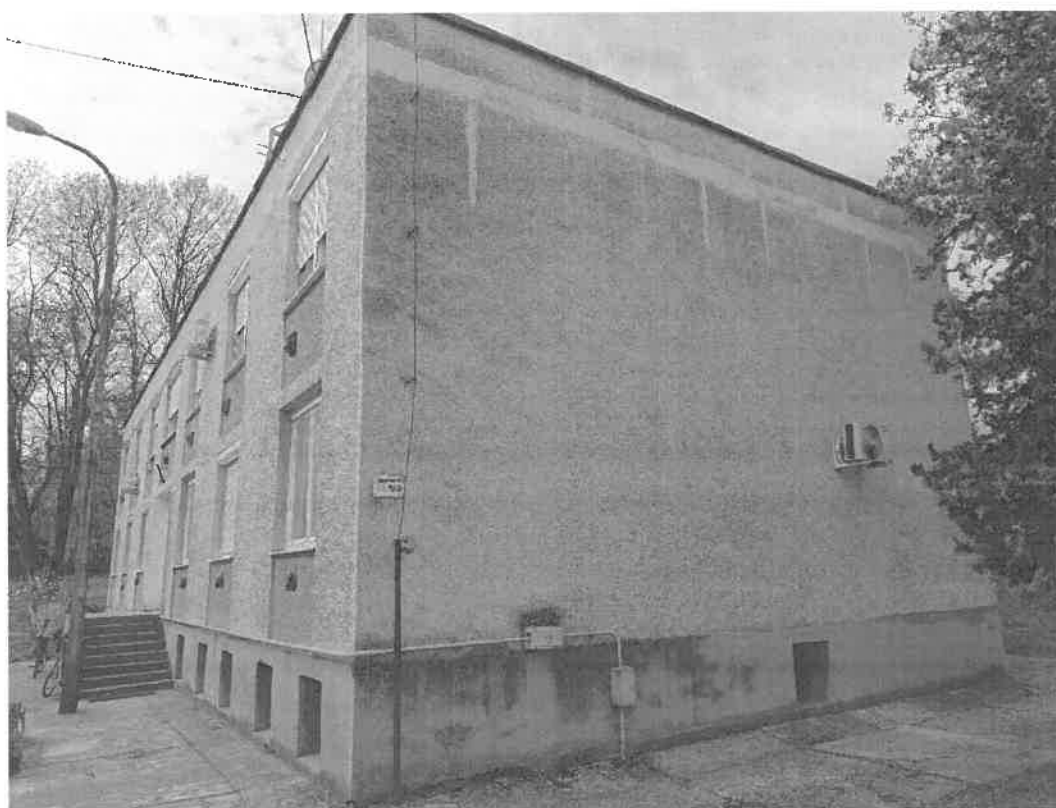
10. kép: az épület északi homlokzata; korábbi vakolatjavítás nyoma látható a emeleti földem vonalában
