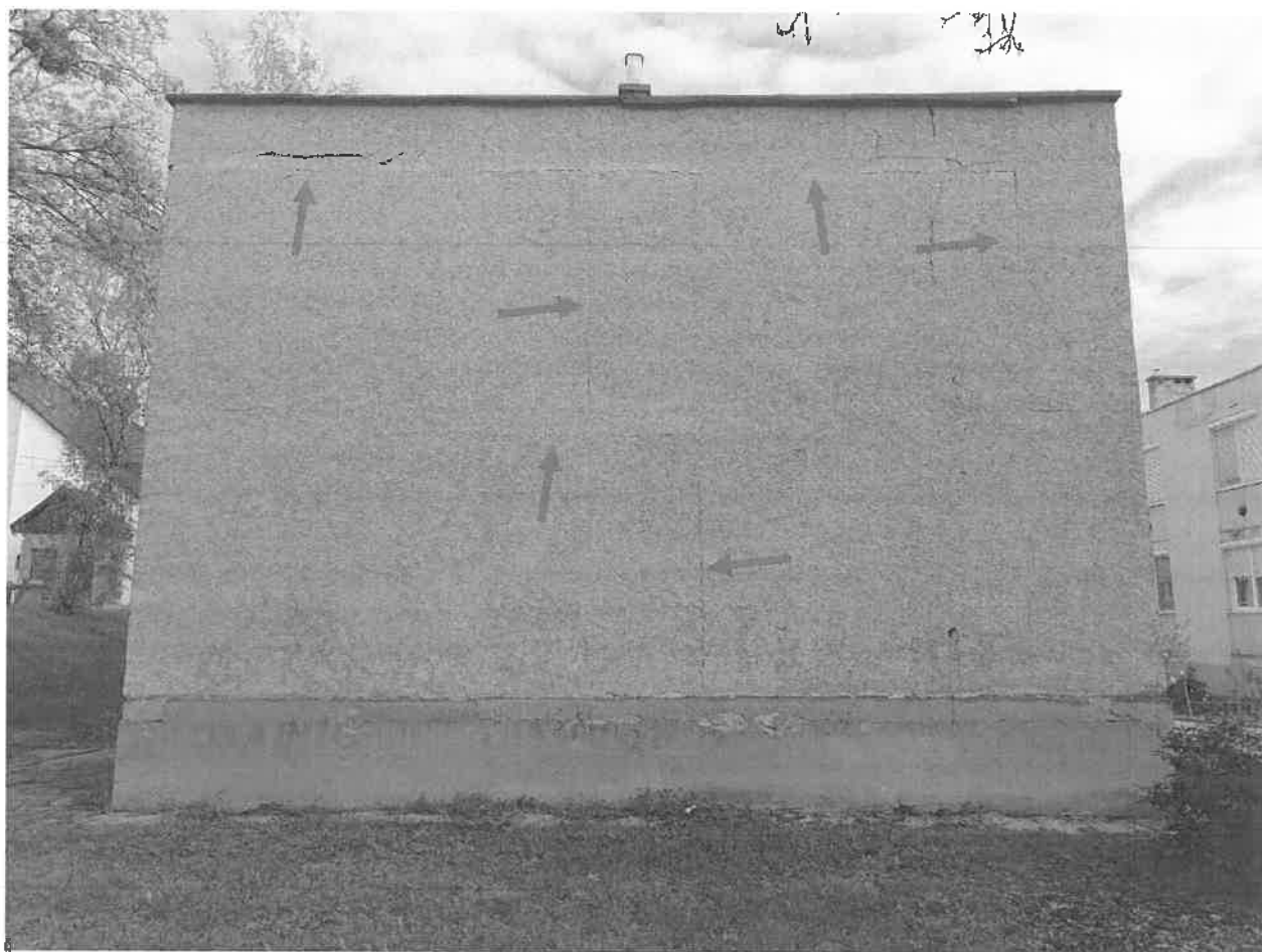
4. kép: a déli homlokzati fal; repedések formájában kirajzolódnak a téglablokkok határvonalai és a földemek (koszorúk) vonalai
