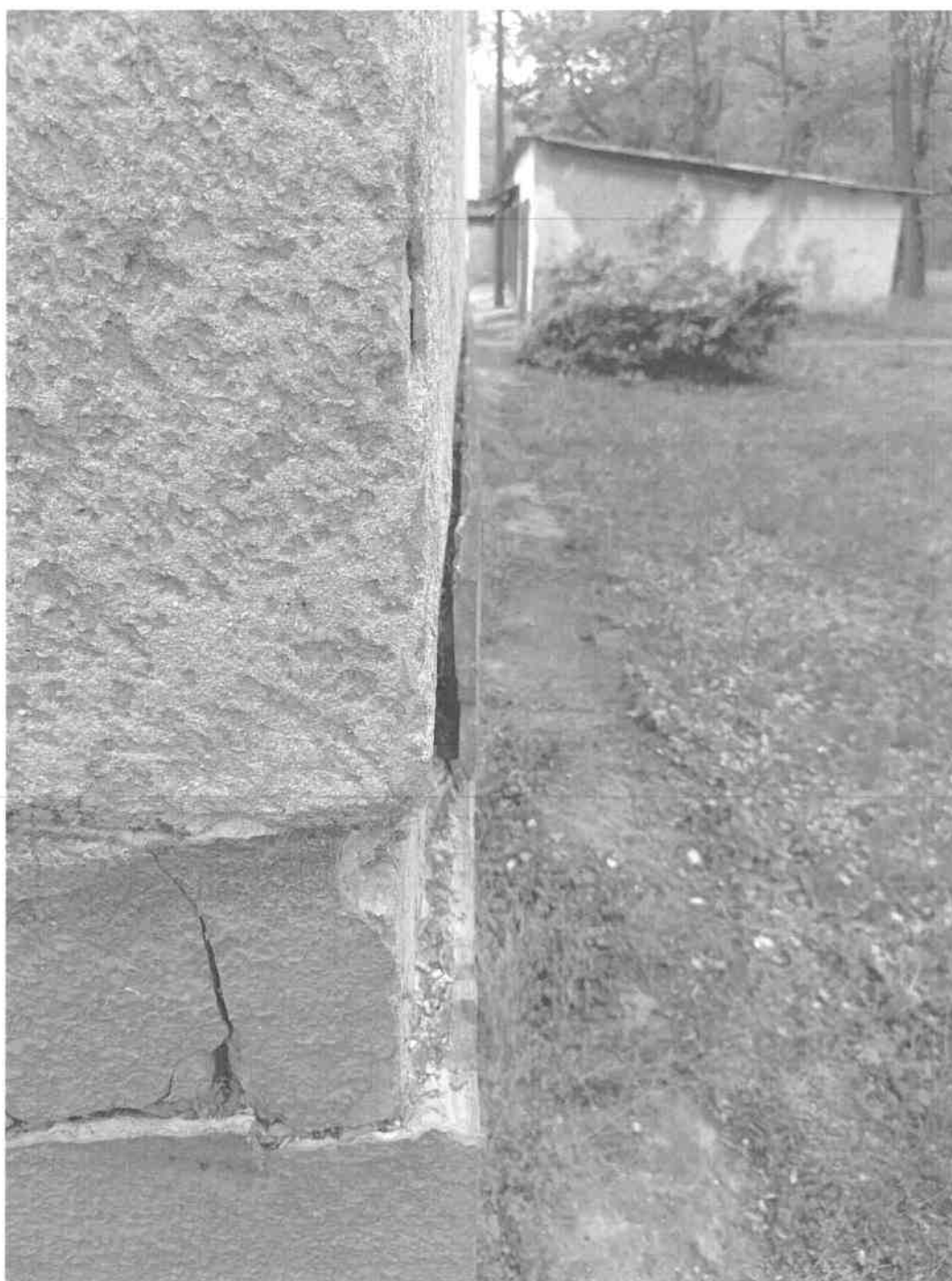
8. kép: a lábazat felső része a fal síkjától kb. 3 cm-t elmozdult kifelé
