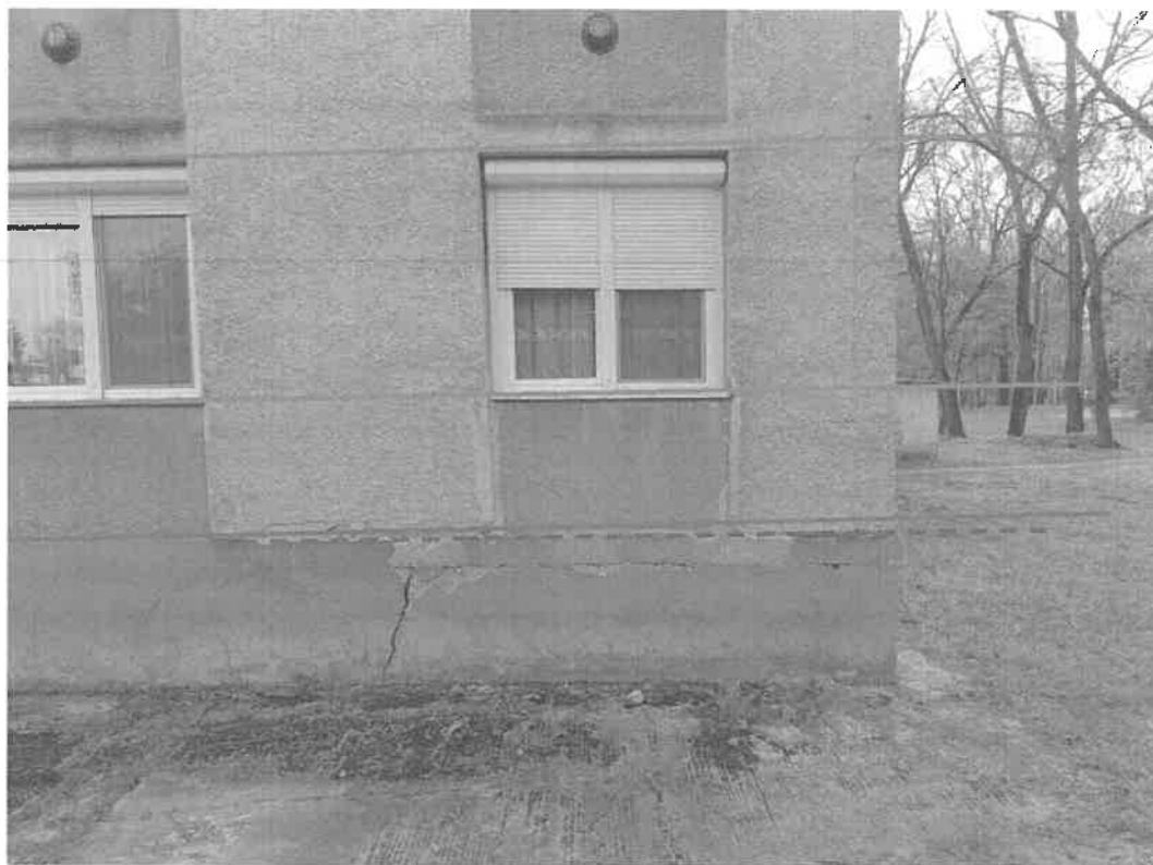
7. kép: szabad szemmel látszik az épület süllyedése, de a képen az elmozdulások érzékeltesére segédegységeket illesztettünk be. Ezek alapján jobban érzékelhető az elmozdulások mértéke. Pl. a piros folytonos vonal a lábazat vízszintes folytatása, szaggatottal a tényleges lábazat felső sík látható. Az eltérés kb. 10 cm!
